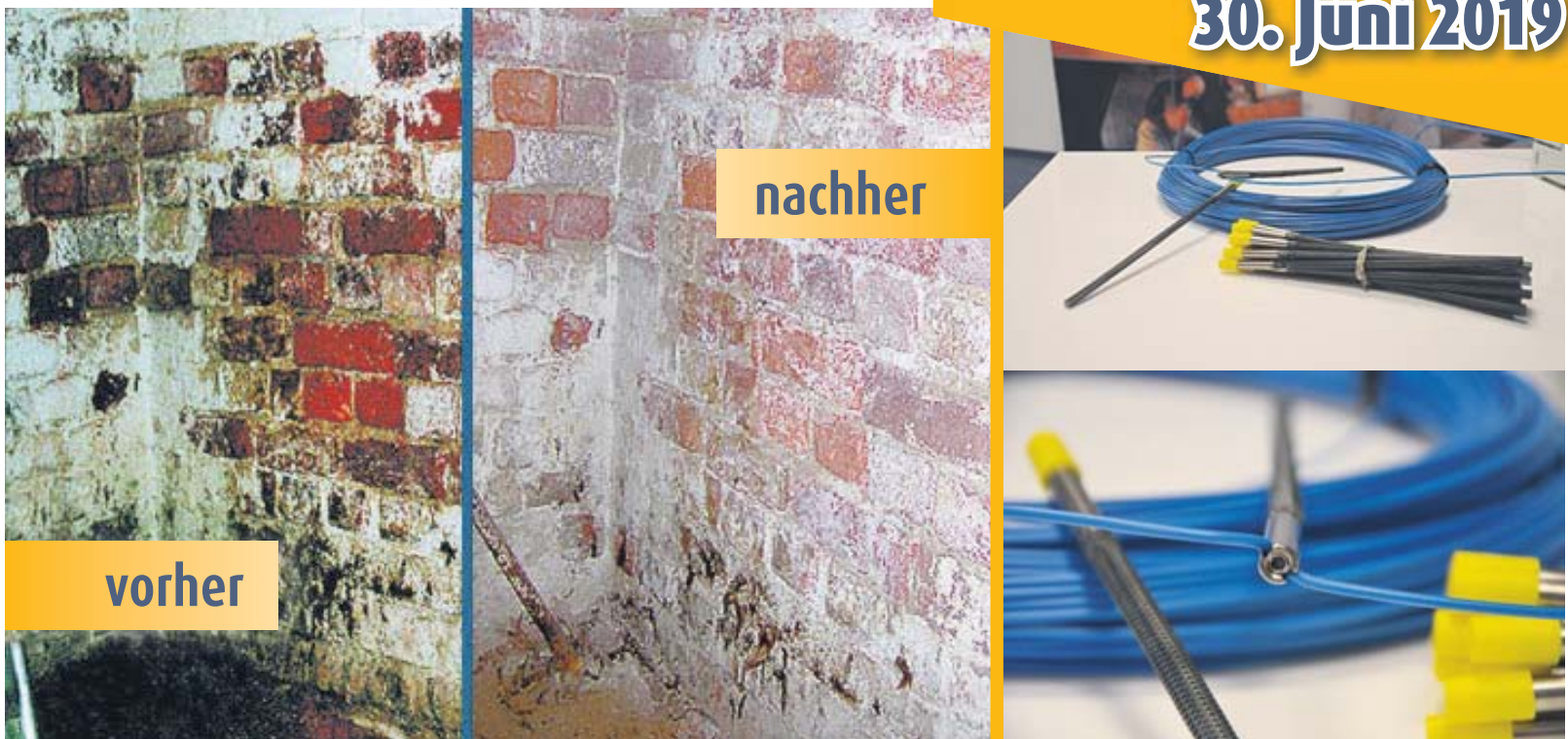
Die Gitteranoden wurden von der DRYMAT-Systeme GmbH gemeinsam mit anderen Unternehmen entwickelt. Foto (2): Ulli Schubert
